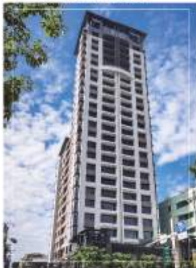
● 正隆天第24層SRC住宅大樓
